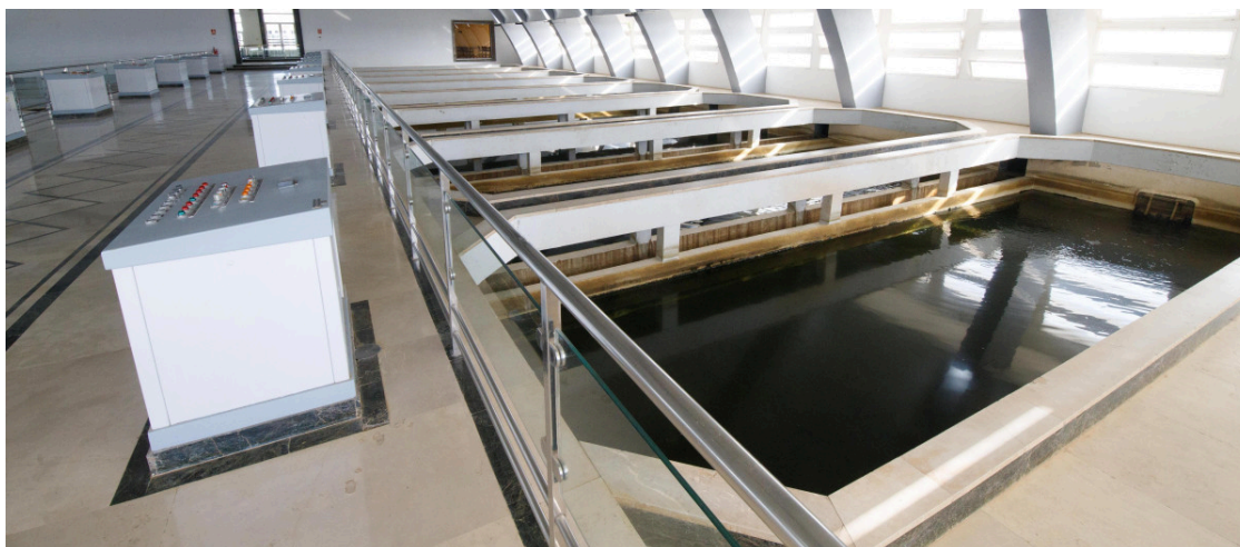
Estación depuradora de aguas de Emacsa en Villa Azula Voz
