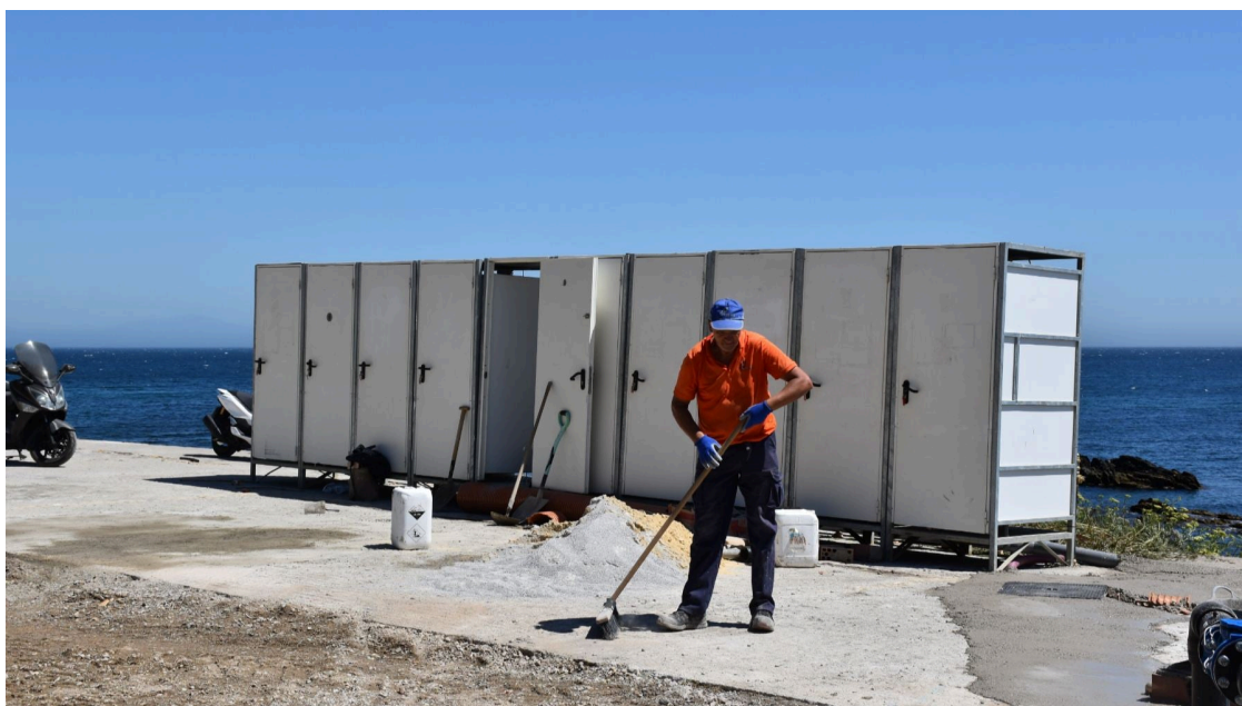
Momento de la instalación de las duchas el pasado 6 de agosto. (Foto: Europa Press).
